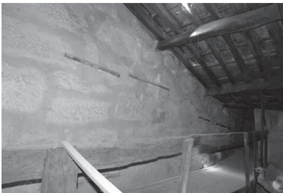
Fig. 06. Igreja dos Congregados - intervenções estruturais: agrafos metálicos (a) na moldura da janela Este da fachada acima do piso do coro, (b) na parede do frontão da fachada (acima da abóbada) do lado Este, (c) na parede sobrejacente ao arco triunfal; (d) juntas refecadas no tímpano do lado Oeste
