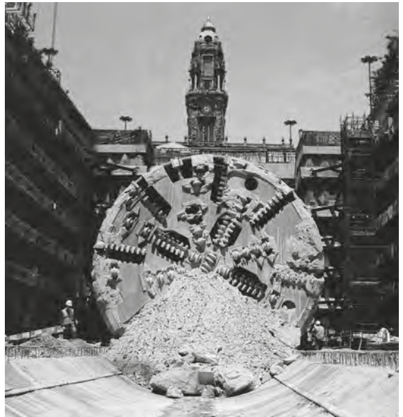
Registro de uma cartografia geológica expedida na frente da tuneladora Tuneladora após chegada à estação Aliados
