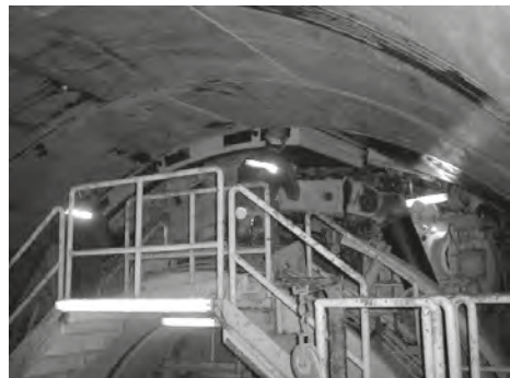
Uma aduela - visível a borracha perimetral de impermeabilização, os conetores laterais e um negativo para um coletor longitudinal Aduela em processo de montagem mecanizada
