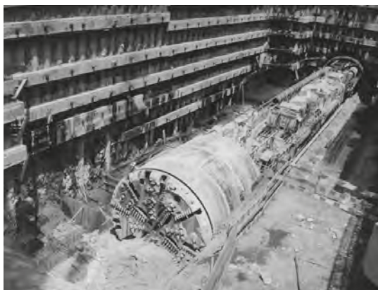
Tuneladora em montagem - visível a cabeça, os 19 conjuntos de macacos e, em primeiro plano, o parafuso sem-fim
