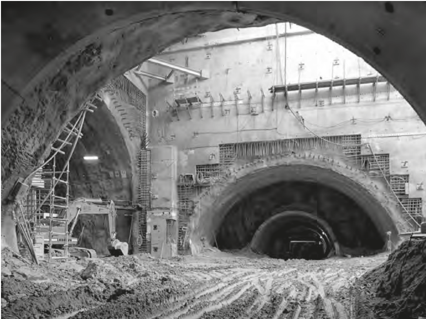
Estação Combatentes - intersecção das galerias principal e transversal, revestimento primário em betão projetado armado
