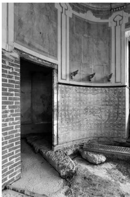
Fig. 60, 61 e 62. Imagens do interior da “Casa Hortícola” durante a obra: painéis de azulejo decorativo com motivos de caça, reboco fingido com efeito marmoreado e escada em caracol de betão de acesso à sobreloja.
