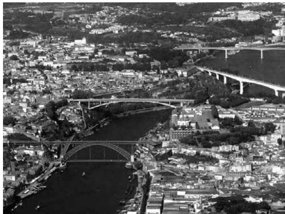
com um vão de 270 m é uma ponte em arco em betão. A ponte de São João, também obra de Edgar Cardoso, inaugurada em 1991, é um pórtico ferroviário de betão armado pré-esforçado com vão de 250 m. Mantém-se como recorde mundial na sua tipologia, localizada a apenas 170 m da ponte Maria Pia, instalou-se ao seu lado sem competir formalmente com a anterior. [Fig. 08]
