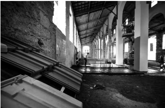
Reforço fundações existentes
