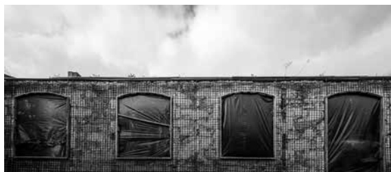
Reforço paredes existentes
