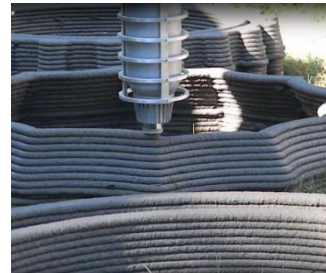
Figura 2.74 - Extrusor da impressora Stroybot em processo de impressão no exterior (Rudenko, 2015).
