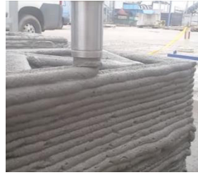
Figura 2.47 – Bocal redondo em processo de impressão (betabram_videos 2015).
