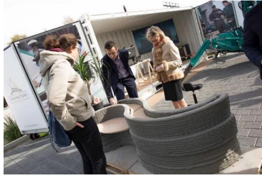
Figura 2.89 - Banco urbano, 200x80x50 cm, 450 kg, camadas de 20 mm de altura, impresso em 55 min (Construtions-3D 2018b).
