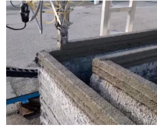
Figura 2.48 – Impressão com o uso do bocal quadrado, onde é visível o uso das espátulas no acabamento lateral (Ribic 2018).
