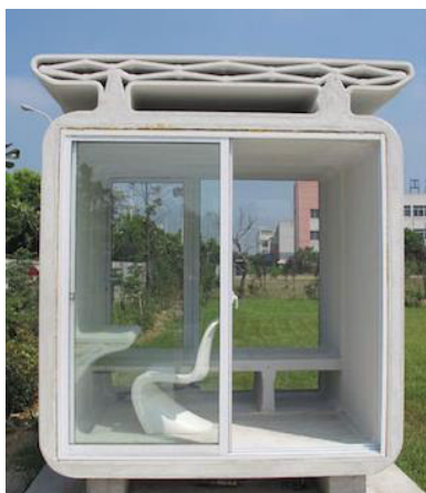
Figura 2.41 - Pequena construção totalmente impressa em materiais cimentícios (Doris 2018).
