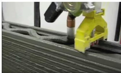
Figura 2.25 - Extrusor com triplo bocal em processo de impressão de uma parede, com reforço interior (Hewitt, 2010).
