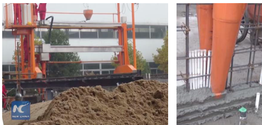
Figura 2.43 – Impressora e pormenor do extrusor desenvolvido pela HuaShang Tegda (New China TV 2016).
