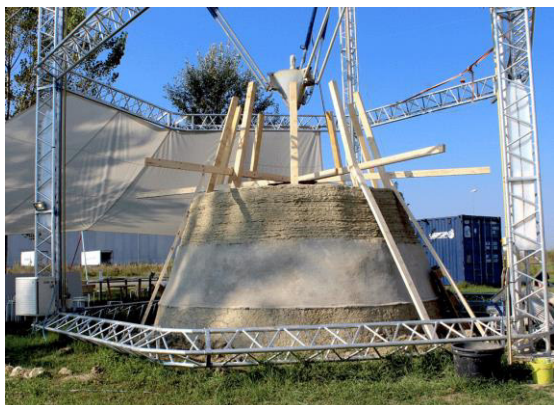
Figura 2.69 - Colocação de estrutura em madeira para suportar o telhado (WASP, 2017d).
