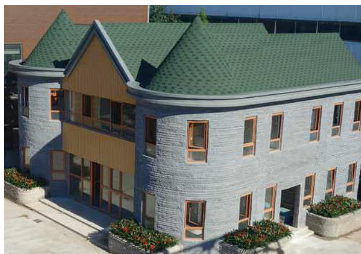
Figura 2.45 - Habitação anterior devidamente acabada (Tengda, 2016).
