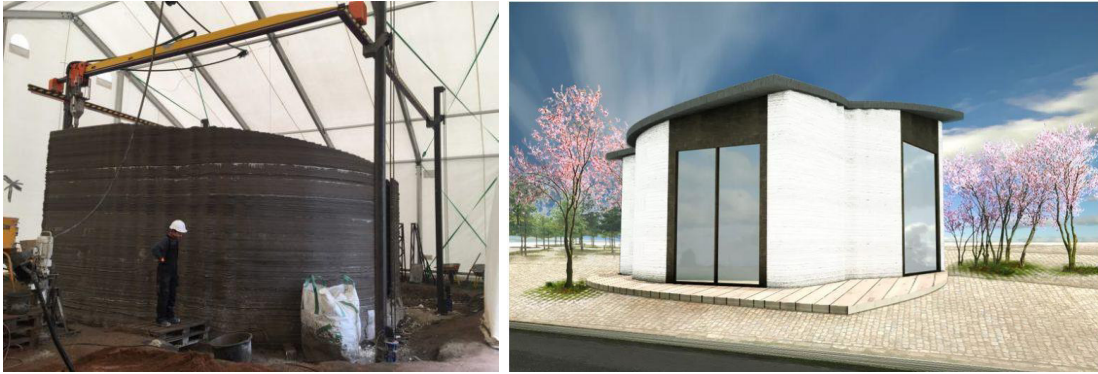
Figura 2.93 - Construção do edifício BOD e render da construção final, respetivamente (Printhuset 2017a).
