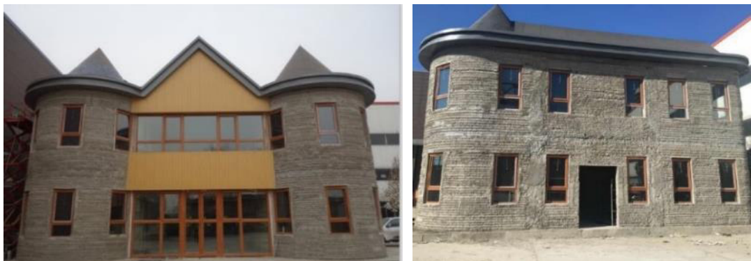
Figura 2.44 - Habitação impressa em betão, no local de construção, durante 45 dias pela HuaShang Tengda (Scott 2016),
