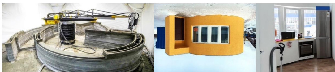
Figura 2.83 - Processo de construção, exterior e interior da habitação, respetivamente (apis cor 2017a).
