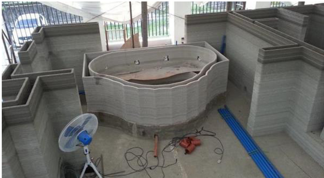
Figura 2.77 - Pormenor da impressão de um jacuzzi no interior do hotel junto com parte da sua estrutura.
