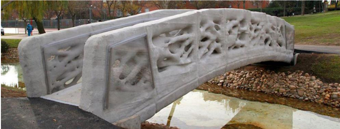
Figura 2.22 - Ponte pedonal em Alcobendas, Madrid, com 12 m de comprimento e 1,75 m de largura (BEYOND 2015).
