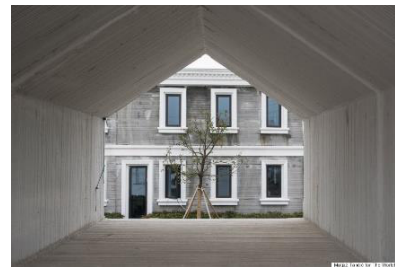
Figura 2.40 - Interior de uma habitação impressa em betão (Matjaz Tanc Ic).
