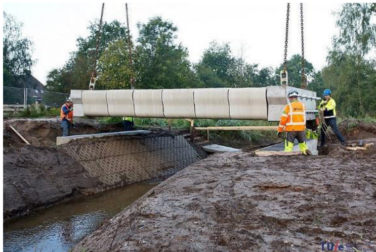
Figura 2.94 – Instalação da ponte no local da obra (TU/e 2018a).
