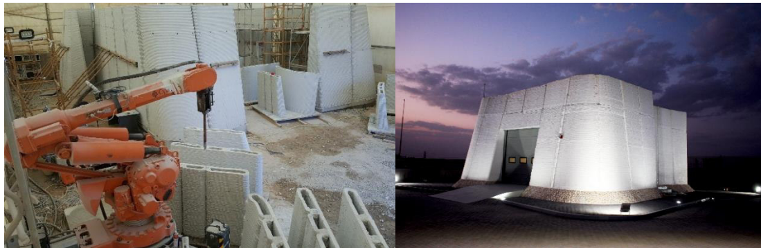
Figura 2.55 - Redrone Laboratory, edifício de desenvolvimento e produção de Drones, impresso pela impressora CyBe RC 3Dp (CyBe Construction 2017e).
