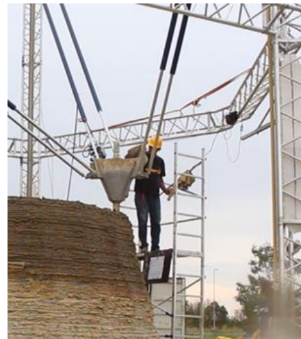
Figura 2.66 - Processo de abastecimento do extrusor da Delta Big 66 (WASP 2017a).
