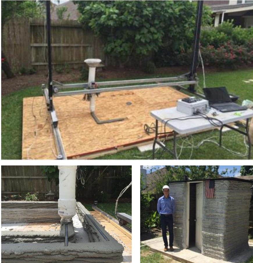
Figura 2.78 - Impressora V2 Vesta 3D em processo de impressão no exterior, e habitação impressa (Alec 2016a).
