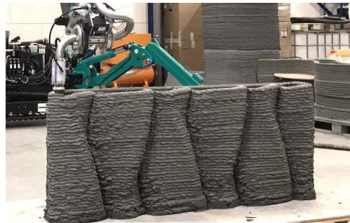
Figura 2.91 - Protótipo de parede, 150x30x90 cm, 550 kg, camadas com altura de 10 mm, impresso em 1h03 (Construtions-3D 2018b)
