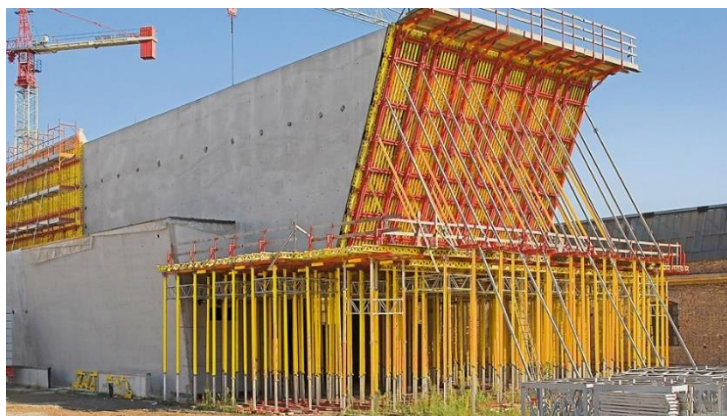
Figura 2.11 - Cofragem do edifício MAXXI - Museo nazionale delle arti del XXI secolo, Italy (Coffrages, 2003-2009).
