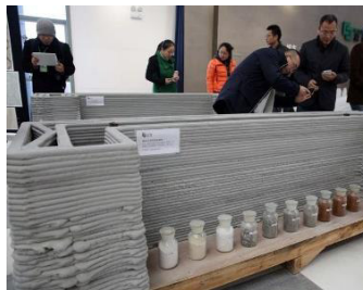
Figura 2.38 - Parte de uma parede impressa pela WinSun (Caxin, 2015).
