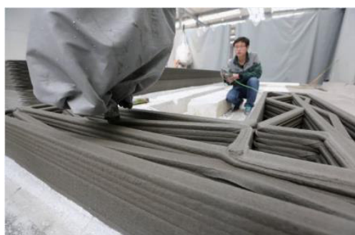
Figura 2.37 - Processo de impressão da WinSun Company (Caxin 2015).
