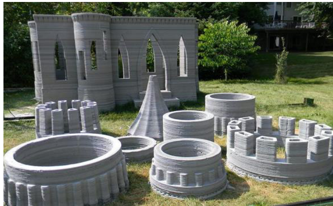
Figura 2.76 - Topo das torres do castelo antes da sua montagem no edifício (Rudenko 2014a).
