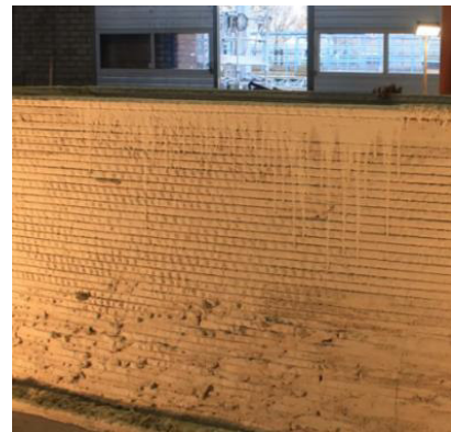
Figura 2.52 - Parede impressa pela impressora R 3Dp (CyBe Construction 2014).
