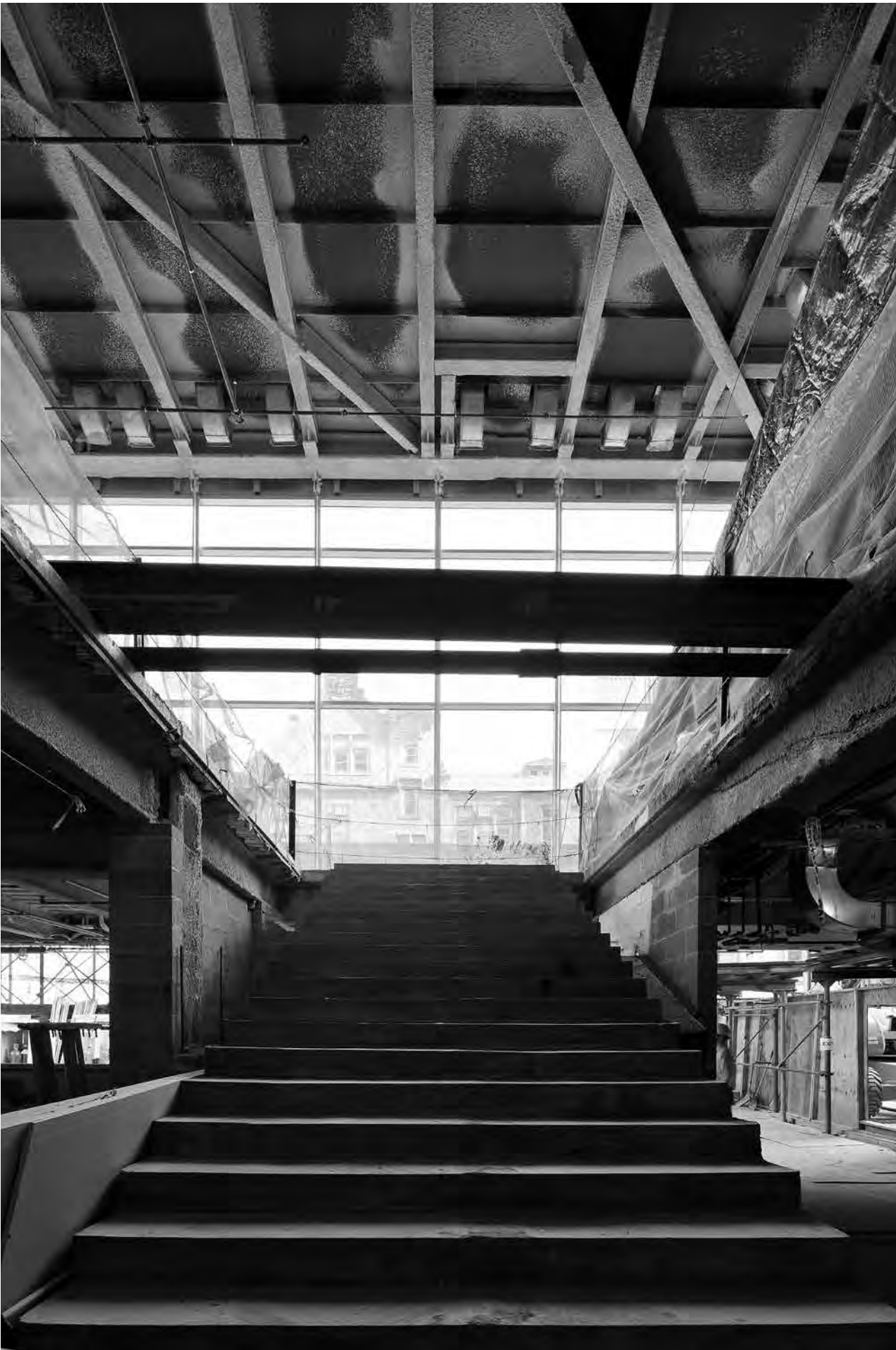
Acesso à cafeteria durante a construção, 2009 Cafeteria stairs under construction, 2009
