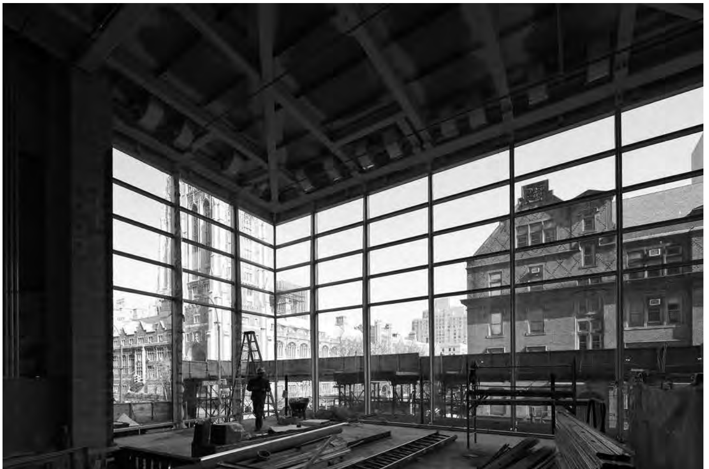
Interior da biblioteca durante a construção, 2009 Library under construction, 2009
