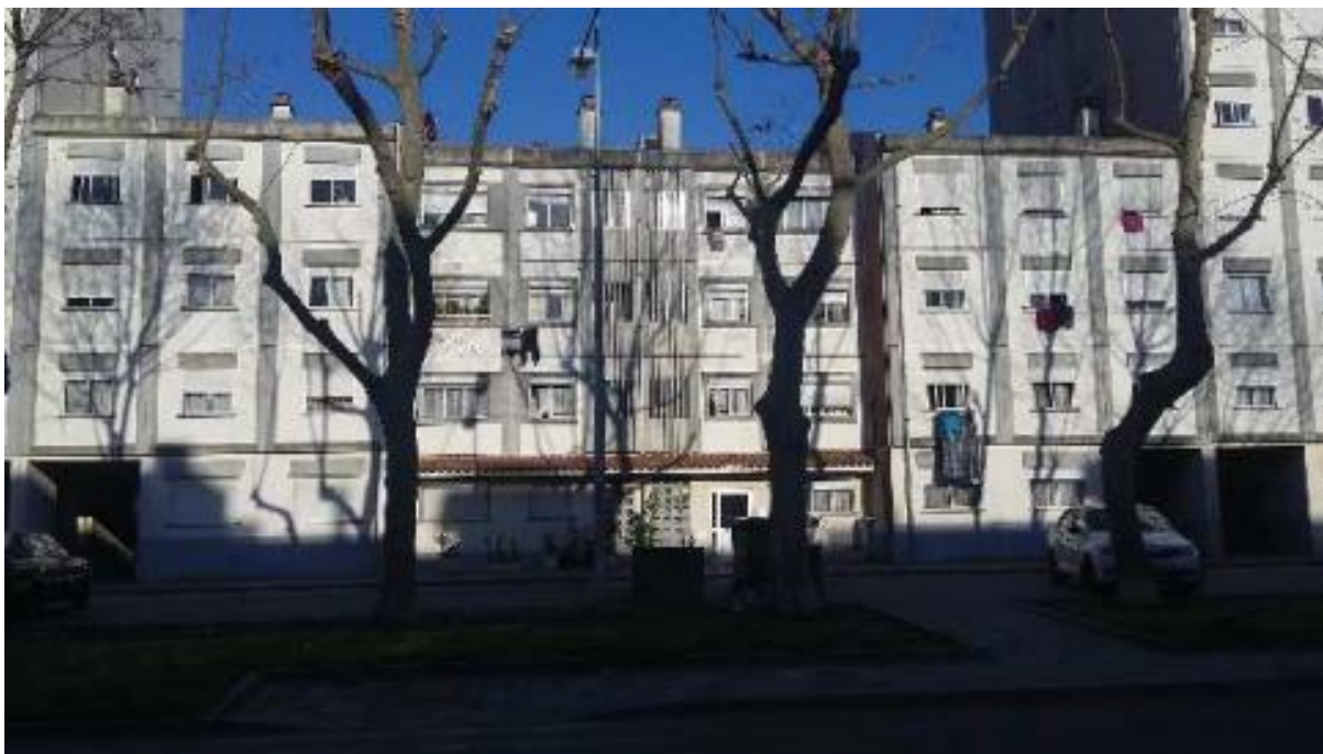
Fig. 4 Bloco tipo B, Bairro Santiago-Aveiro [14]
