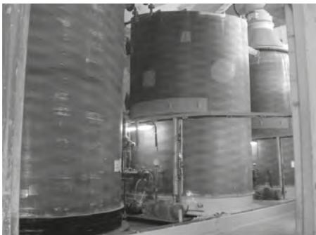
O processo de desodorização aplicado na estação de tratamento é do tipo adsorção gás-líquido. Os lavadores utilizados são torres de enchimento plástico que funcionam em contracorrente, com a adição de reagentes de neutralização (ácido sulfúrico, hipoclorito e soda).
