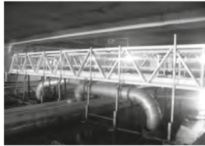
Após sofrer um processo de desgaseificação o efluente seguirá graviticamente em direção aos decantadores secundários.
