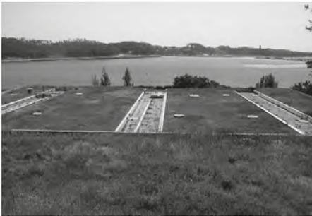
Este tipo de tratamento permite o funcionamento dos reatores biológicos de biomassa dispersa em função da evolução das cargas.
