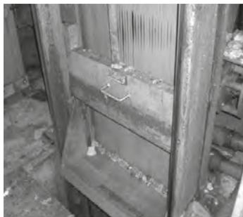
Chegadas à ETAR, as águas residuais sofrem uma gradagem, com vista à remoção dos detritos mais grosseiros de forma a proteger os equipamentos a jusante.
