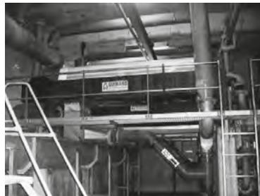
As lamas homogeneizadas na bacia de mistura de lamas são desidratadas em duas de três centrífugas, existindo uma terceira como reserva mecânica das outras duas.
