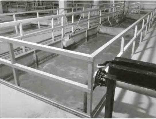
em suspensão. As lamas decantadas são raspadas por intermédio da ponte raspadora de fundo para quatro fossas situadas junto aos cantos da zona de decantação e encaminhadas para a bacia de mistura de lamas. O efluente depurado é recolhido por transbordo sobre caleiras na parte superior e é enviado para tratamento secundário ou biológico enquanto as lamas se vão acumular na parte inferior do decantador.
