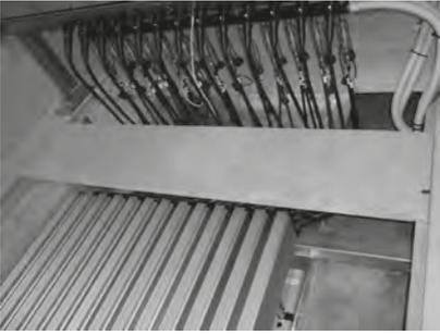
A desinfecção por raios ultravioletas utiliza a propriedade que possuem os UV, no comprimento de onda de 254 nm, de destruir os microrganismos por rutura das cadeias de ADN portadoras da informação genética.
