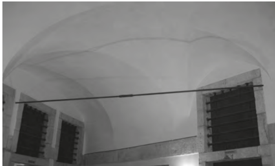
Fig. 58 Tirantes metálicos no interior do edifício.
