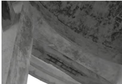
Armaduras à vista nas vigas de travamento e cintagem
