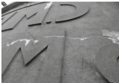
Fissuras horizontais na face exterior do reservatório
