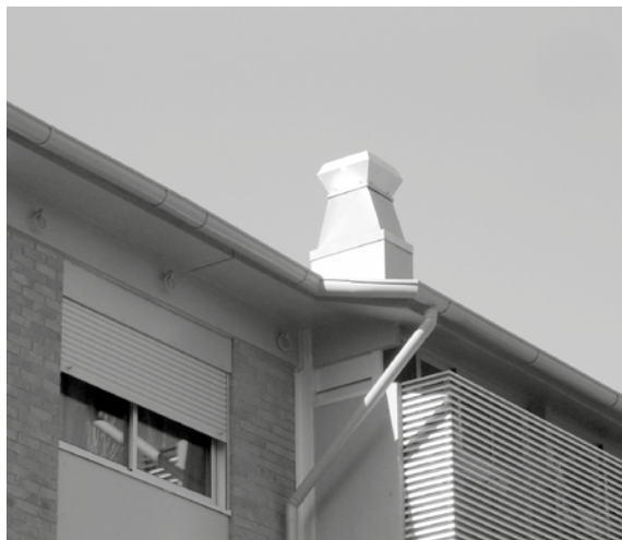
Fig. 16. Sistema de ventilação mecânico, antes e depois
