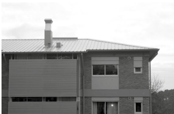
Fig. 15. Intervenção nos vãos exteriores
