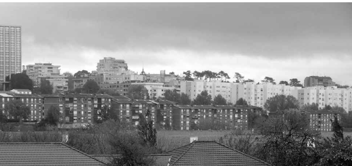
Fig. 01. Vista geral antes da intervenção
