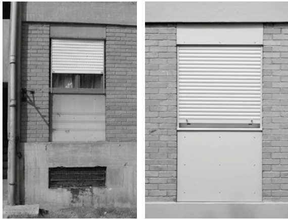
Fig. 17. Estores exteriores, antes e depois
