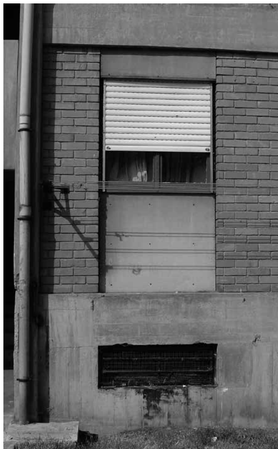
Fig. 05. Estado inicial - paramentos adjacentes aos vãos exteriores, com revestimento de placas de fibrocimento
