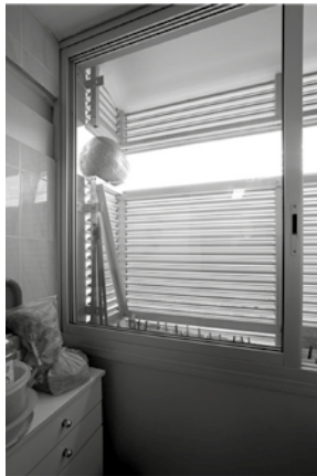
Fig. 18. Estado atual da Lavandaria
