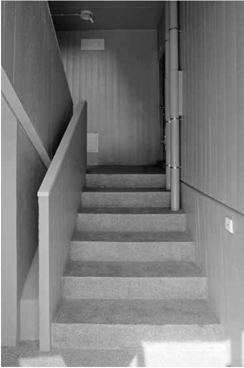
Fig. 20. Proposta para a passagem de infraestruturas elétricas
