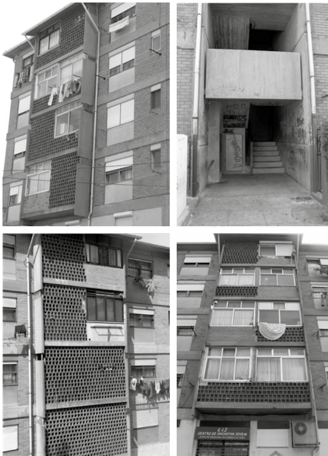
Fig. 08. Estado inicial – vistas gerais
