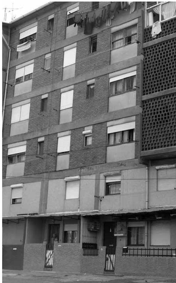
Fig. 07. Estado inicial - alçado posterior do bloco 15
