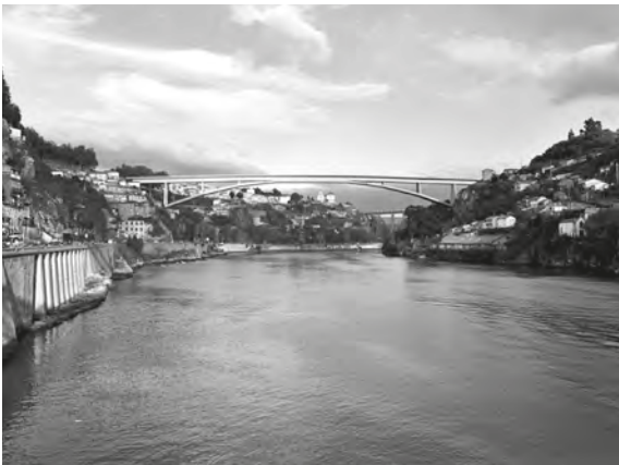
Fig. 2. Alçado da Ponte já construída, vista do tabuleiro inferior da ponte Luiz I.
