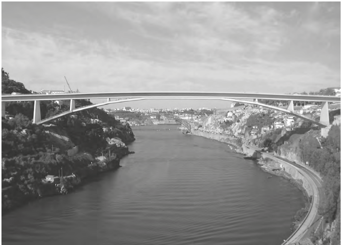
Fig. 1. Alçado da Ponte em final de construção.
