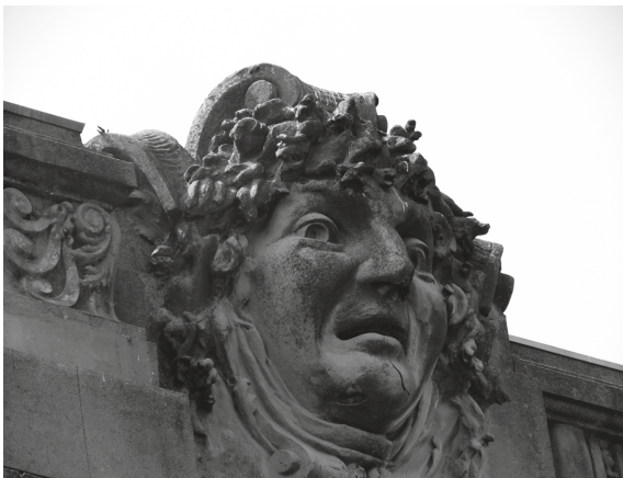
Fig. 46. Junta horizontal na estátua Ódio . Tamponamento do local de extração do carote, 2013
