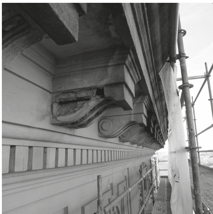
Fig. 29. Varões metálicos nas mísulas, 2013
