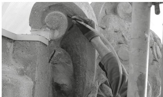
Fig. 63. Remoção dos produtos da oxidação de varões com micro martelo, 2014
