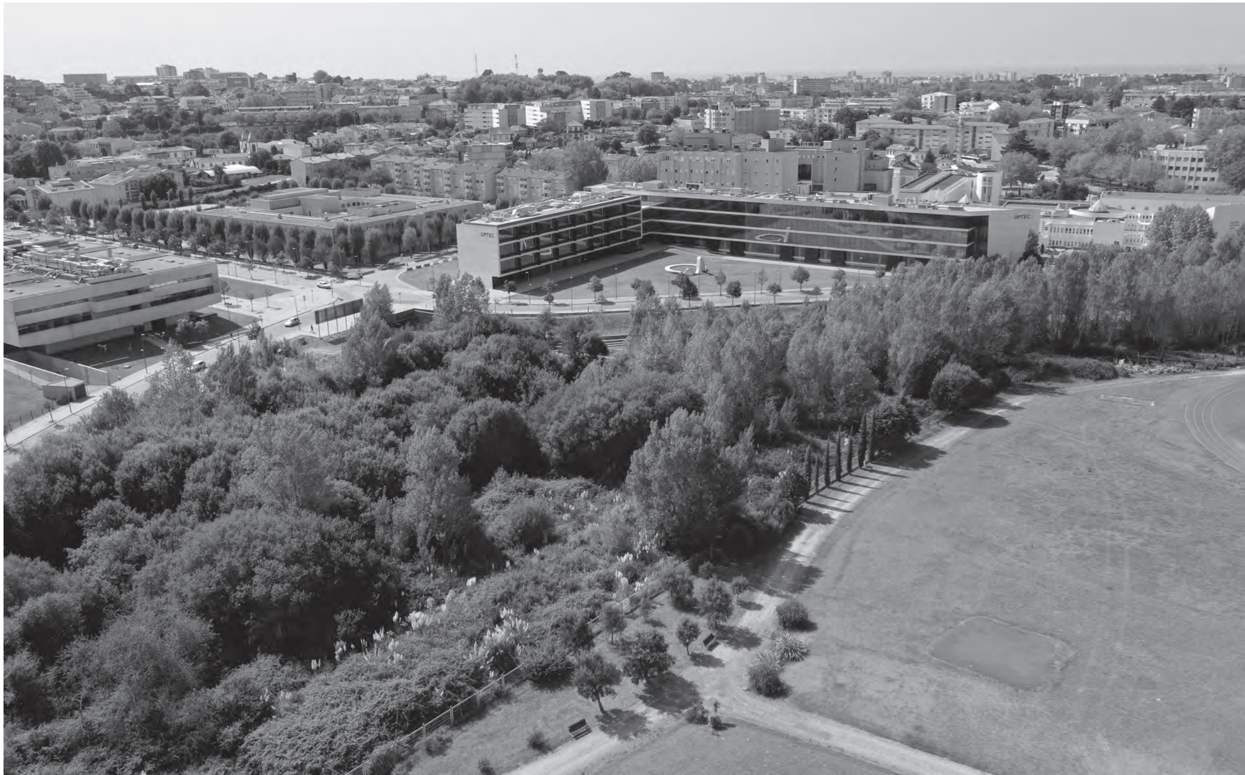
Vista sobre a área de intervenção. Setembro, 2019
