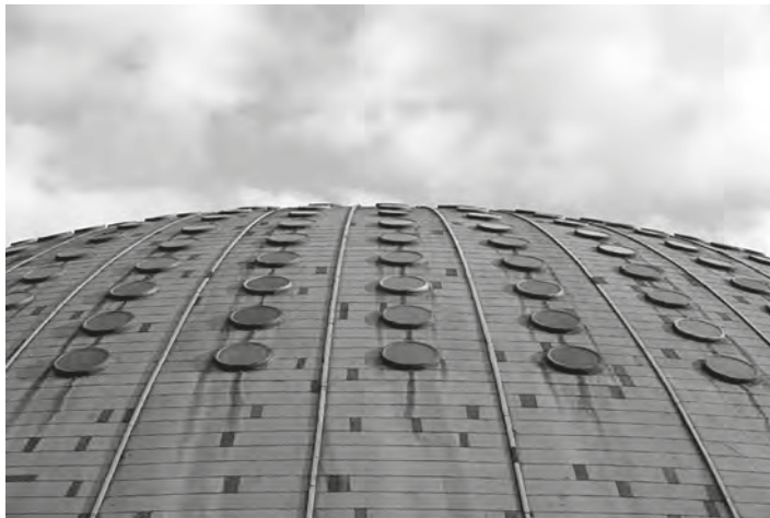
Fotografia da cobertura na atualidade.
