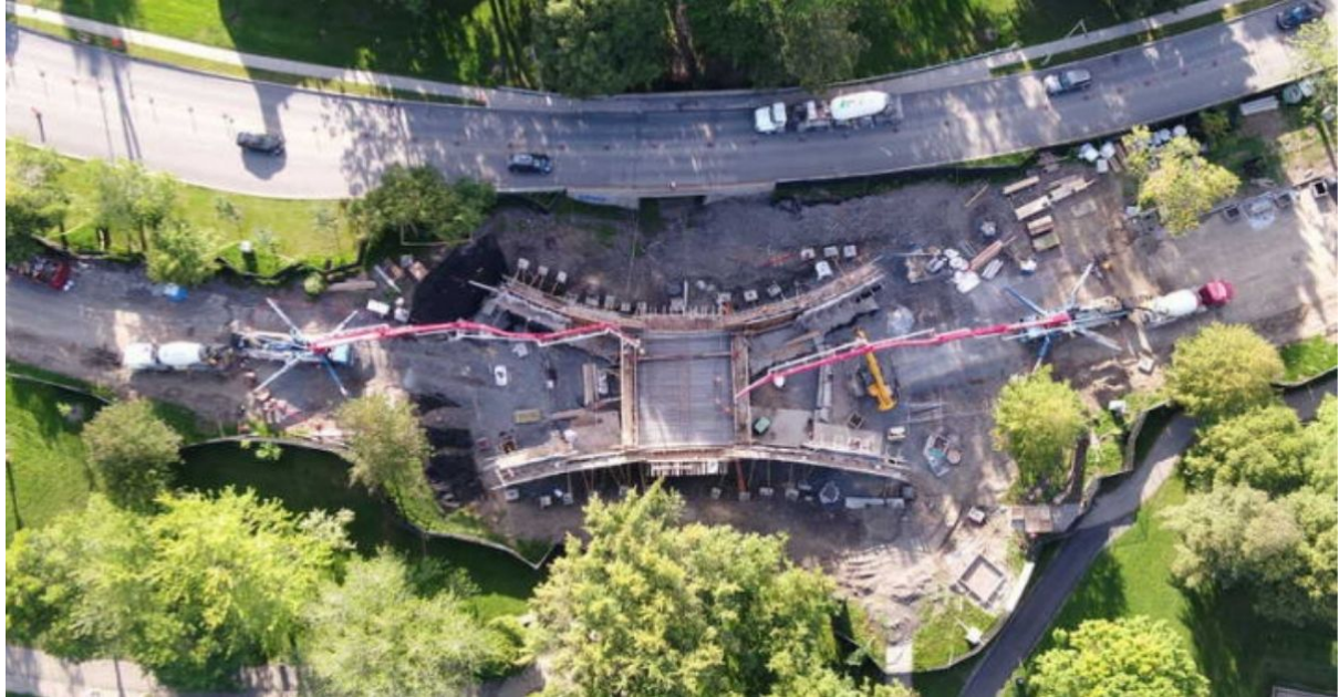
Figura 11 - Construção de ponte com 70 mil garrafas de vidro reciclado em Montreal, Canadá (adaptada de (Montreal's Darwin Bridge Construction Project Uses Recycled Glass - Montreal | Globalnews.ca, n.d.))
